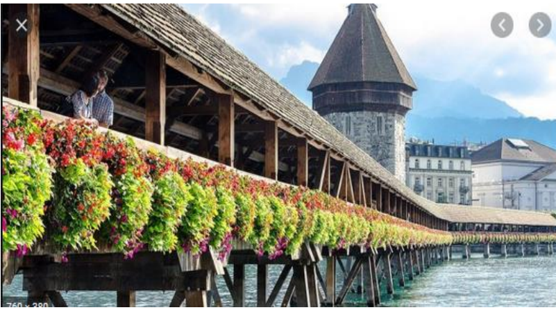
die Kapellbrücke – die älteste Holzbrücke Europas
